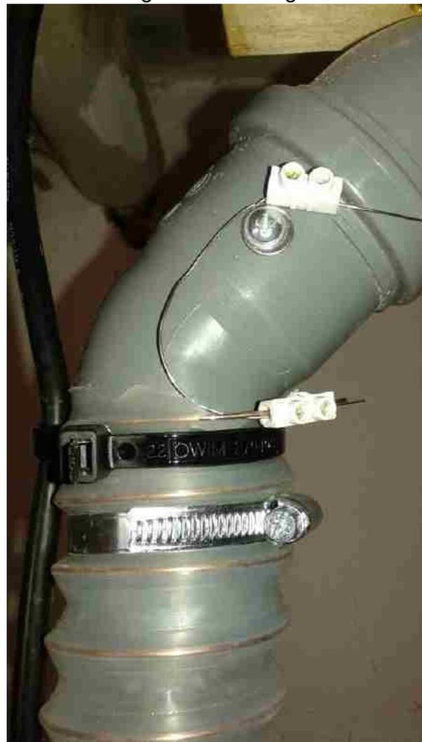
Verschlussdeckel (HT-Muffenstopfen mit Eigenbau-Griff)
